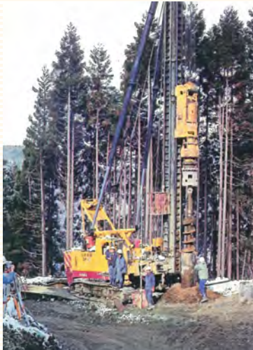
長野オリンピック ボブスレー会場建設 基礎杭工事
