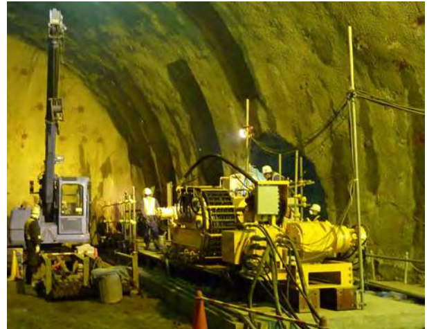
▲水平コントロールボーリング FSC-100
