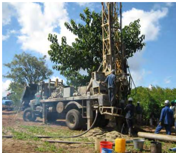
▲マラウィ 水井戸掘さく工事 FSW-7T
