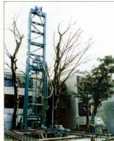
東京瀬田で都市形温泉を掘さく施工 スピードSPAドリルSSD-3000
