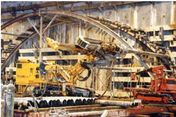
▲パイプルーフ施工現場（神奈川県）RPD-130C
