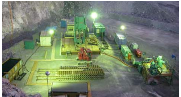
▲津久見鉱山（大分県）径6m×深さ143m立坑掘さく工事 BM-600A
