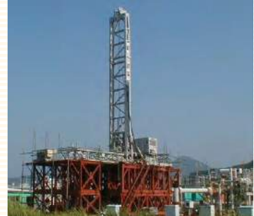
九州電力(株)山川地熱発電所 地熱還元井浚渫 SSD-4000
