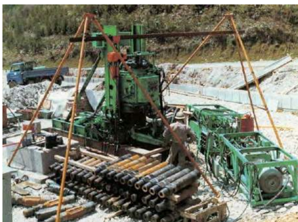
▲徳島県勝浦発電所調圧水槽導坑掘さく工事 BM-100N
