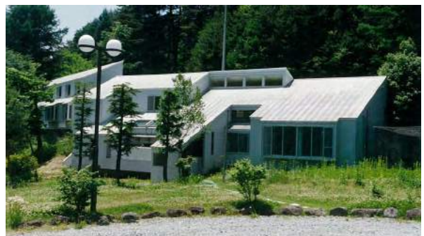
▲鉦研技術研修センター新館
