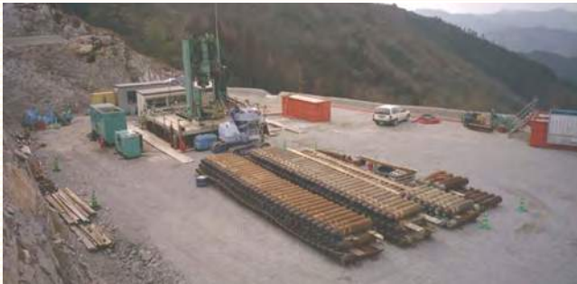
(株)高鉱業社・津久見鉱山立坑掘さく工事 ビッグマン BM-500A
