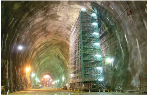
▲波方基地（愛媛県）（写真提供：㈱大林組）地中深くの巨大空間が液化石油ガスで一杯になる
