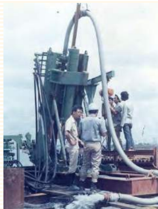
シンガポール・GATEX栈橋基礎杭工事
