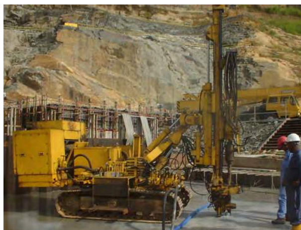
▲サマナラウエアダム グラウト工事 RPD-65LCE
