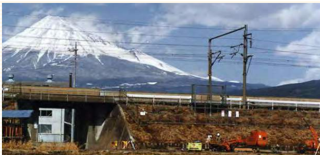
東海道新幹線・タイロッドアンカー工事 RPD-65LCE
