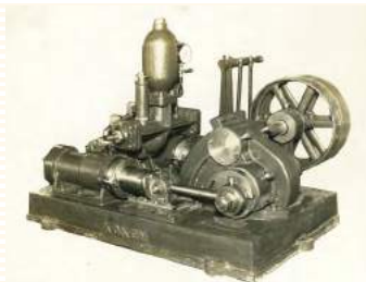
ブランジャー式のボーリング用ポンプ KH-5
