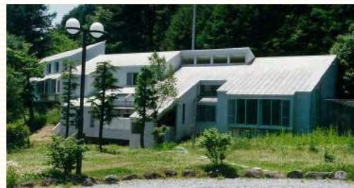
鉦研技術研修センター新館完成
