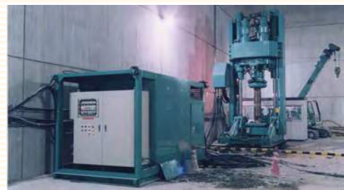
関西電力(株)奥多々良木発電所 調圧水槽立坑掘さく工事 BM-500A
