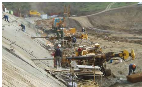
▲アルジェリア アンカー工事 アロードリルRPD-150C
