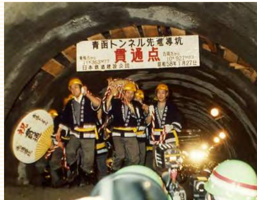
青函トンネル貫通
