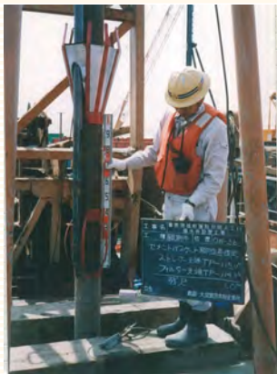
東京湾横断道路 人工島観測井掘さく工事
