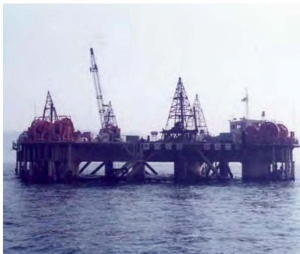
▲明石海峡海上調査ボーリング
