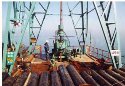
関西国際空港 第2期工事
