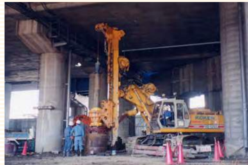
高速道路高架橋の補強工事 BMC-200SS
