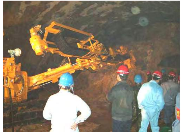
▲中国 厦門（アモイ） 海底トンネル前方調査現場 RPD-180CBR
