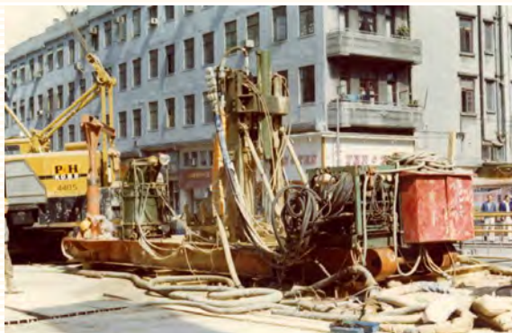
香港地下鉄・土留杭工事
