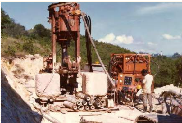
シンガポール大学建設工事のビッグマンによる基礎杭工事
