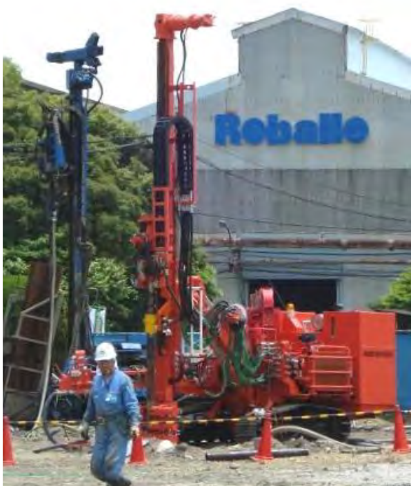
▲掘さく中のロータリーバイブレーションドリル RPD-150C(3)-VNT-3M
