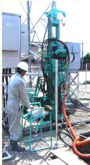
アース棒埋設孔掘さく機アロードリル RPD-50C (パイプレーションヘッドK-50付)
