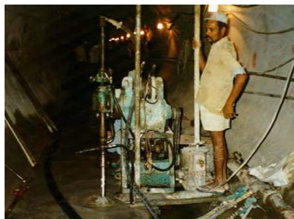
▲サマナラウエアダム グラウト工事
