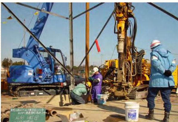
東京電力(株) 小口径鋼管杭工事
