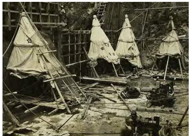
▲小河内ダム建設（東京都）
