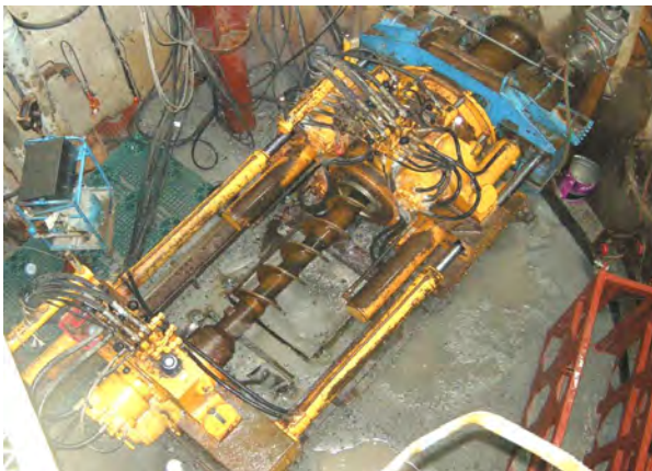
▲韓国 金海市 多目的用水・濾過集水ボーリング中のFS-120-KG3
