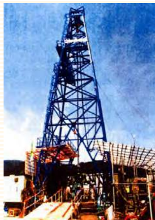
1,500m 湯温68℃ 新潟県巻町温泉ボーリング工事
