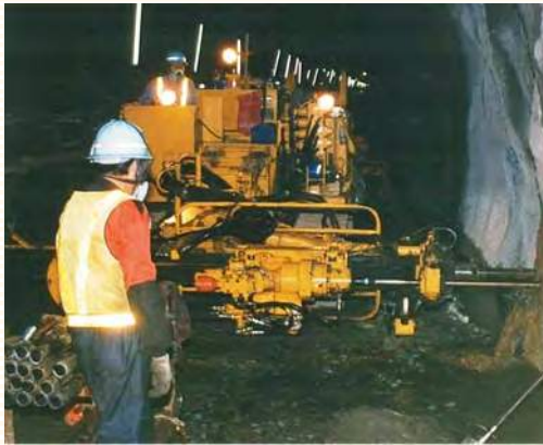
久慈地下石油備蓄水封ボーリング工事(岩手県) アロードリルRPD-75C-E2
