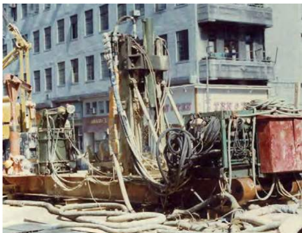
▲香港地下鉄 土留杭工事 BM-50N
