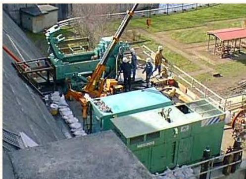
様似ダム(北海道)堤体水平ボーリング BM-100N によるロックモール工法
