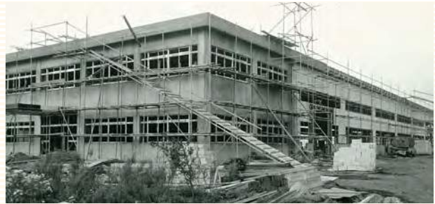
建設工事が進む厚木工場
