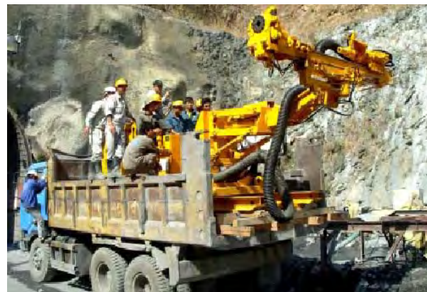
▲ベトナム 水力発電所のアロードリル RPD-45
