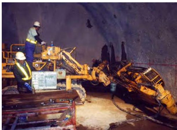
▲八甲田トンネル(青森県)先進ボーリング(PS-WL工法) RPD-130C
