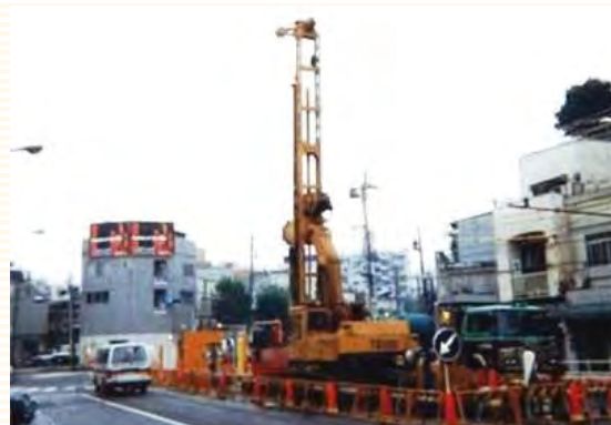
東京都内 地下鉄障害物除去工事 BG-7
