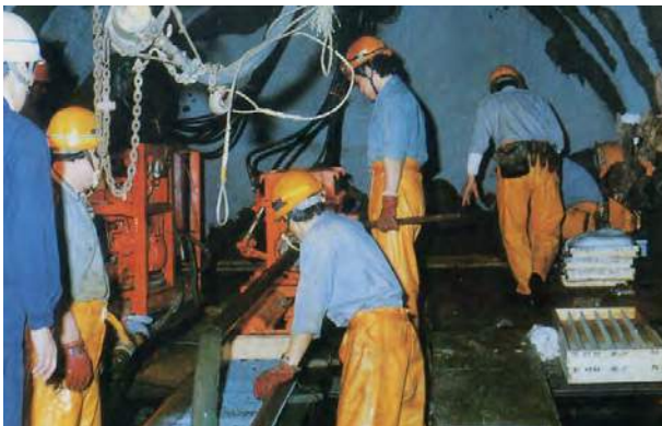
▲青函トンネルの水平ボーリング
