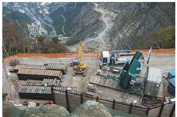
▲青海鉱山（新潟県）径4.75m×深さ470m斜坑（下向き75°）掘さく工事 BM-600A
