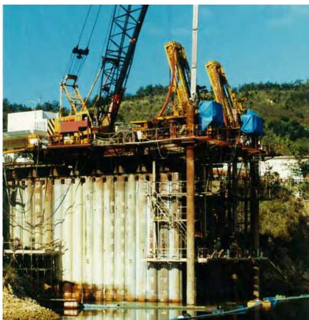
▲福地ダム（沖縄県）鋼管矢板締め切り工事 RBB-100A
