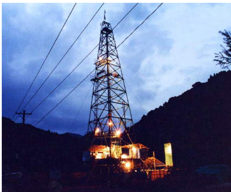
福島県奥会津地熱現場 全景▶
