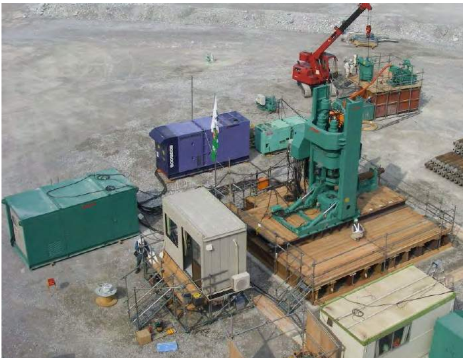
▲津久見鉱山（大分県）グローリーホール 立坑掘さく 径 6,000mm 深さ 143m BM-600A
