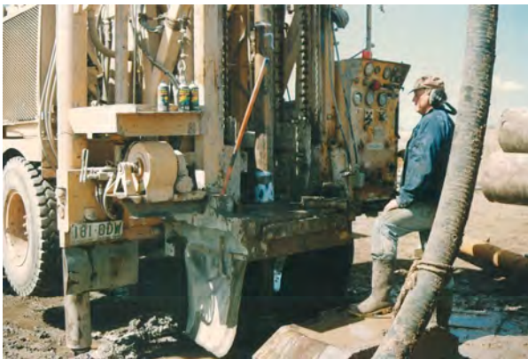
▲中空のDTHによるコア採取急速ボーリング（オーストラリア）
