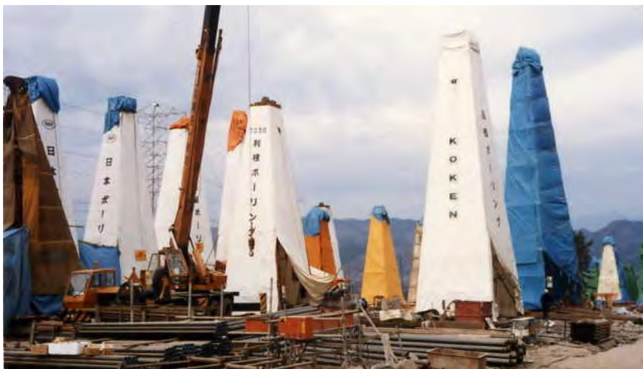
▲上越新幹線中山トンネル グラウト孔掘さく
