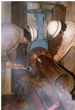
沖縄宮古島皆福ダム(地下ダム) 集水ボーリング工事
