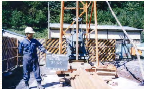
防災科学技術研究所地震観測井掘さく EP-1W
