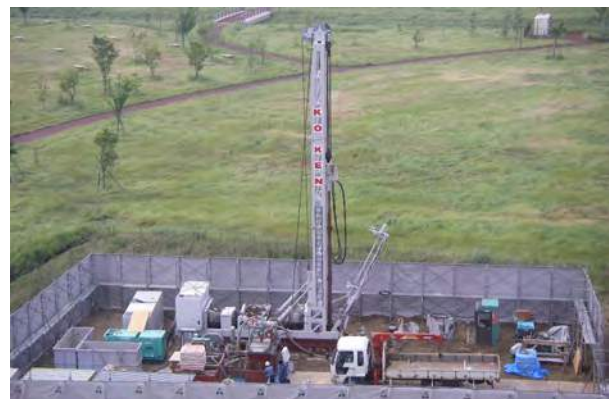
▲船小屋（福岡県）温泉掘さく中のスピードSPAドリル SSD-3000
