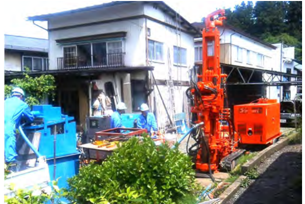
▲水井戸掘さく中のロータリーバイブレーションドリル RVD-50C
