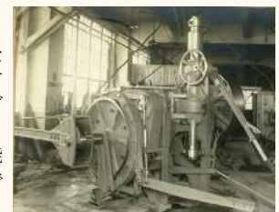
歴史的な第1号機と なったハンドフィード 式KR-Dボーリング マシン。 1,200mの掘進能力は、当時の国産で は最大級を誇った。
