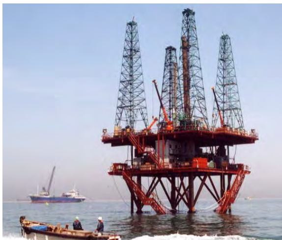
▲関西国際空港2期埋立部計器埋設ボーリング工事 CR-2B
