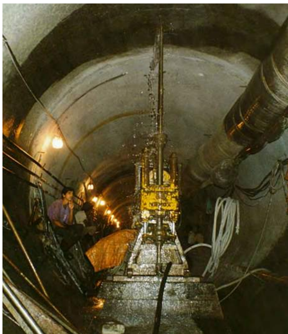
▲スリランカ・サマナラウエアダム グラウト工事
