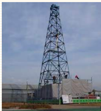
防災科学技術研究所大阪地震観測井掘さく
