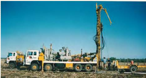
オーストラリアでの高速ボーリング技術開発実験現場
