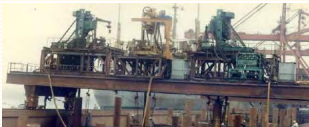
新日鉄君津橋基礎杭工事 ビッグマン BM-100N
