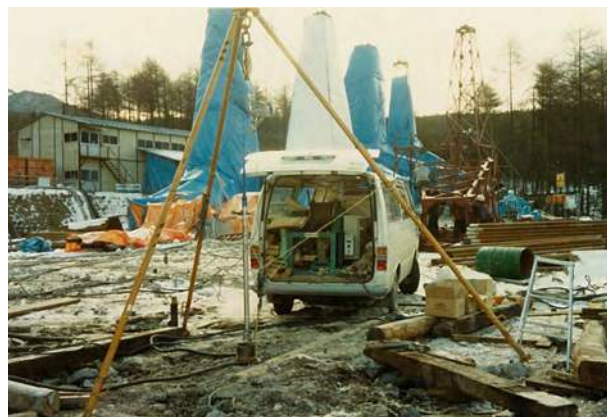
▲連続孔曲がり計測
