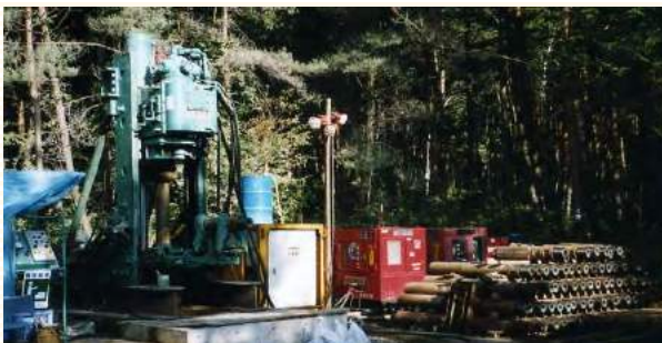
長野県茅野市玉川美濃戸地区水源さく井工事
