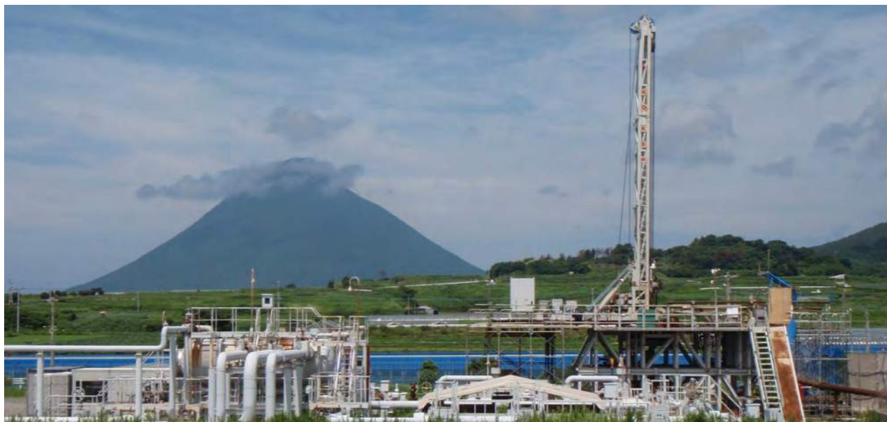
▲鹿児島県山川地熱還元井の浚渫ボーリング中のスピードSPAドリル 最新鋭機SSD-4000 背景は開聞岳
