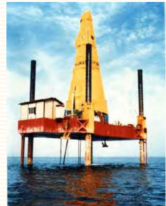
三井有明海 海上ボーリング (深度565m)
