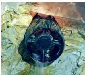
▲奥清津第二発電所 (新潟県) 圧力管路斜坑掘さく工事 BM-150A
