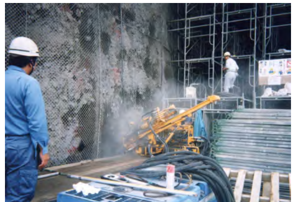
▲ロックボルト施工現場（北海道）RPD-30L
