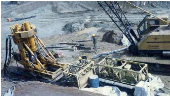
▲中国自動車道西宮北インター（兵庫県） 地すべり抑止杭工事 BM-100N
