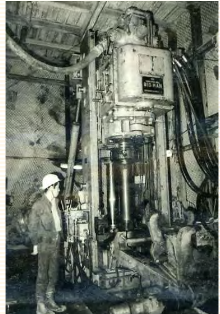
三菱金属鉱業(株)下川鉱山で、ビッグマンBM-100Nにより掘さく長300mの通気立坑を施工
