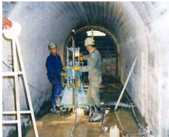
▲アルジェリア シェルファダム グラウト工事
