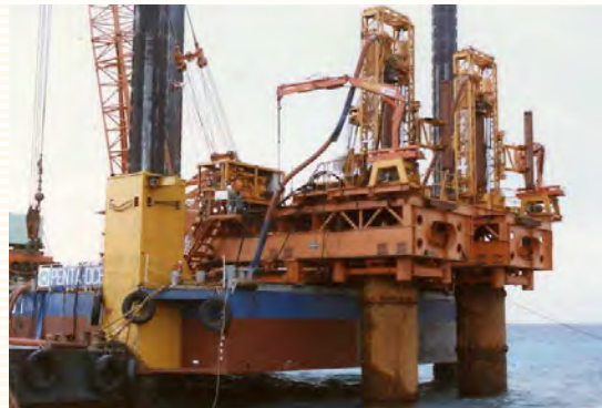
サウジアラビア海上基礎杭工事 RBB-100A
