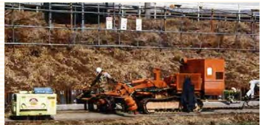
東海道新幹線・タイロッドアンカー工事 RPD-65LCE
