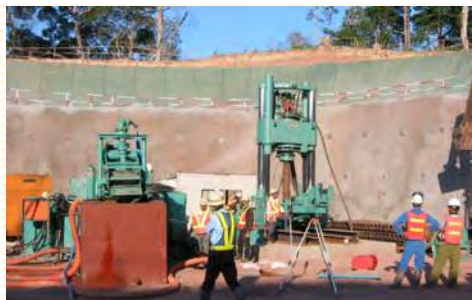
ラオス・ナムツアンダム調圧水槽立坑掘さく工事 ビッグマン BM-150A
