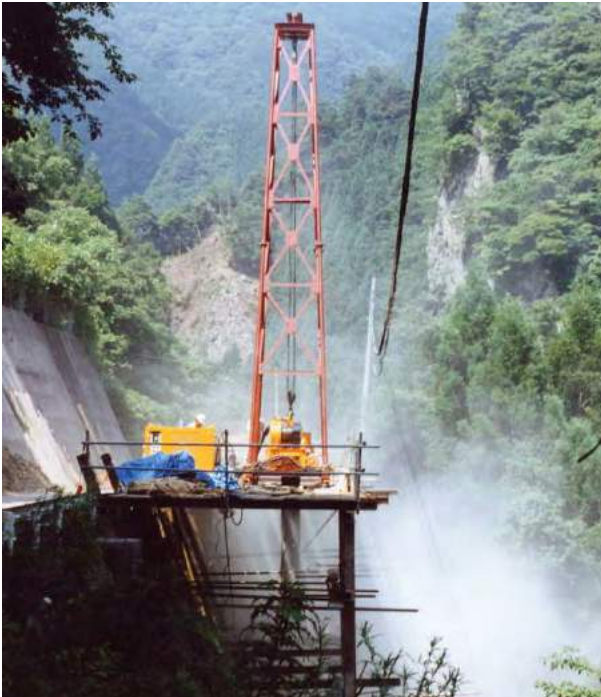
▲RTP-680A現場（徳島県）
