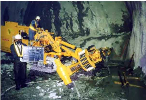
▲トンネル前方調査ボーリング（PS-WL工法）RPD-150C
