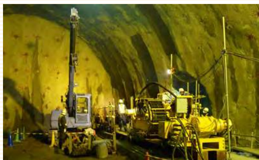
水平コントロールボーリング FSC-100
