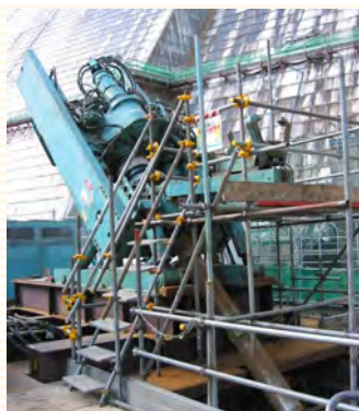
山形県長井ダム導水路斜坑掘さく工事 ビッグマン BM-500A
