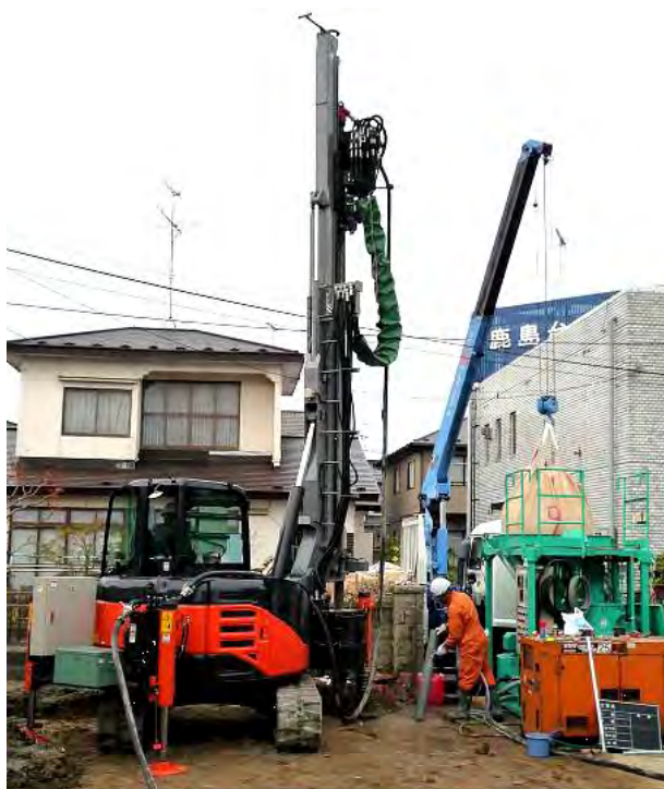
▲施工中の地盤改良機 FSPG-50BC
