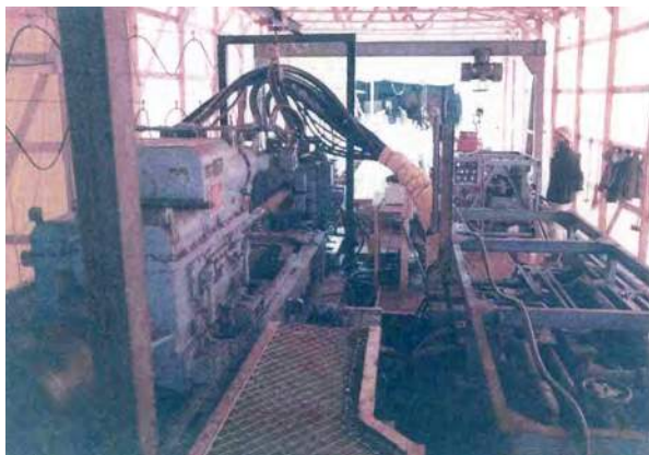
▲中津川線神坂隧道（長野県）の長尺水平ボーリング FS-400B
