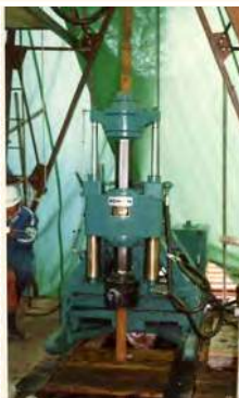
上越新幹線中山トンネル・グラウト注入孔掘さく工事
