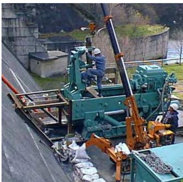
▲様似ダム（北海道）魚道用水平坑掘さく（ロックモール） BM-100N
