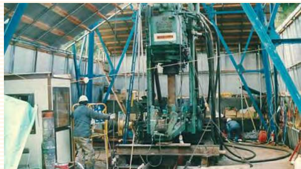
安房トンネル 立坑水抜き工事 BM-100N
