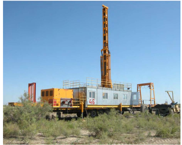
▲カザフスタン ウラン採鉱用さく井工事に稼働中のKZ800C
