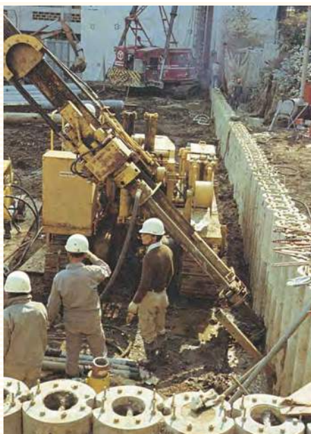
RPD-1 による現場施工
