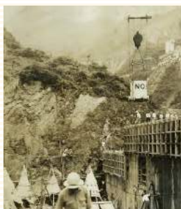
工事中の東京・小河口内ダム
