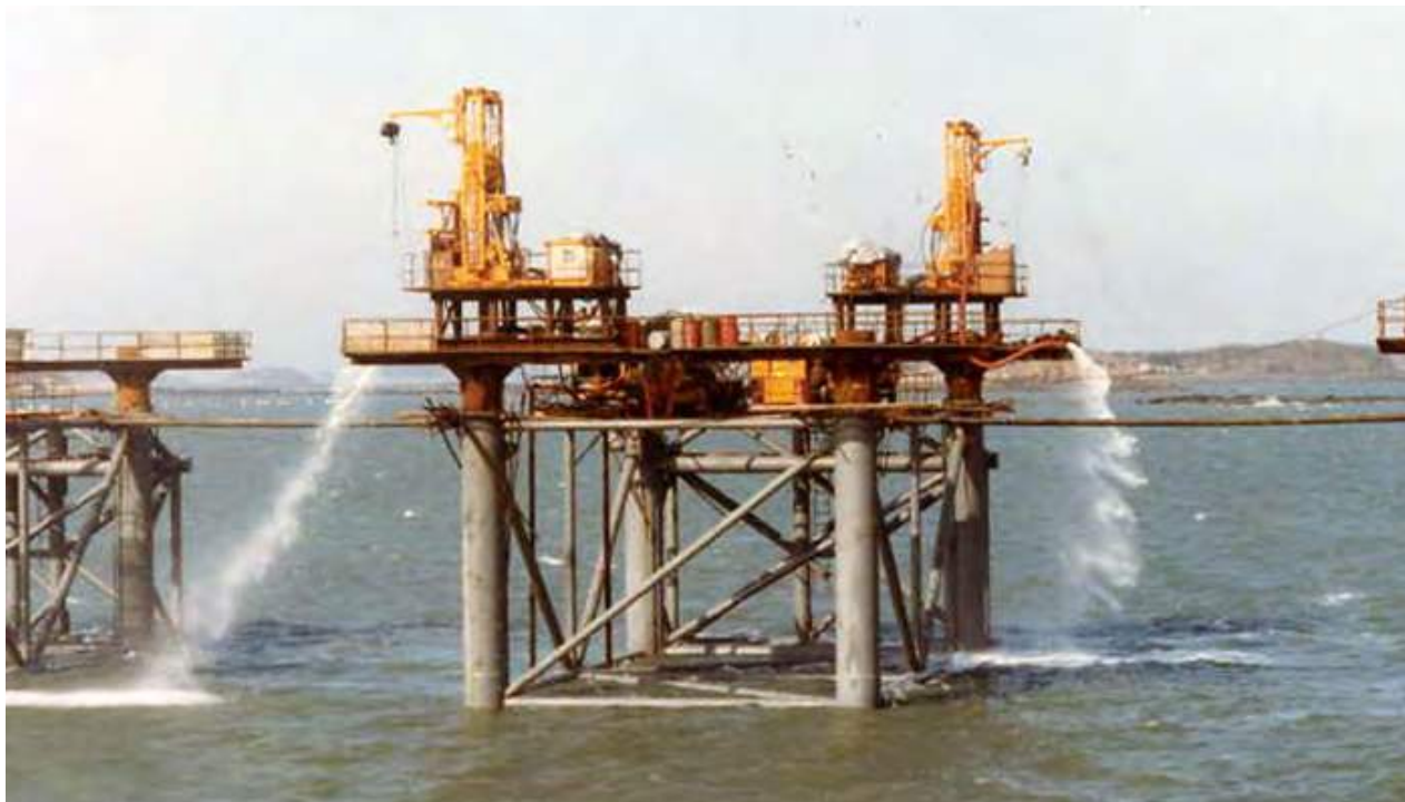
▲韓国 海上基礎杭工事 RBB-100A
