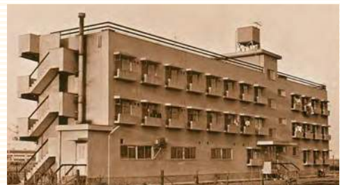
相模寮と命名された鉄筋3階建ての独身寮も同時に完成した。
