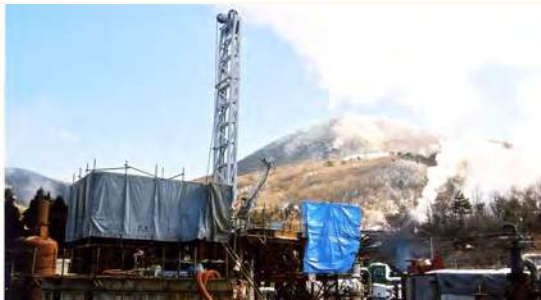
九州電力㈱八丁原発電所(大分県)地熱還元井浚渫工事 スピードSPAドリル SSD-3000
