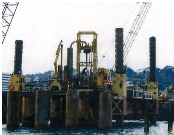
▲シンガポール セントーサ道路橋海上基礎杭 RBB-100A
