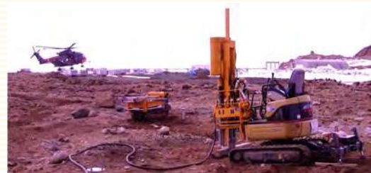
南極でアンテナ設置孔掘さく作業中の ソニックドリル ED-15P
