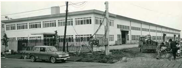
新工場の建物(手前が工場事務所、その奥が工場)。
