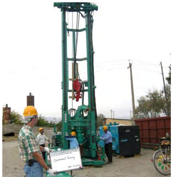
▲タジキスタン リバース工法大口径水井戸掘さく機FSR-75A
