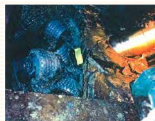
奥清津第2発電所 圧力管路斜坑掘さく工事 BM-150A
