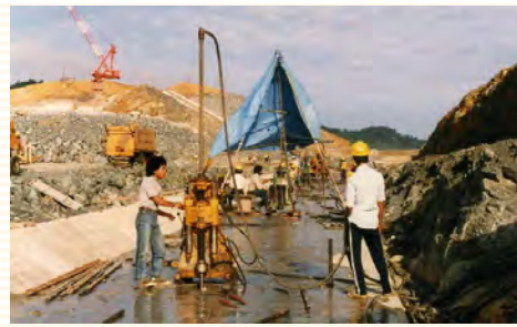
東マレーシア・パタンアイダム、グラウト工事
