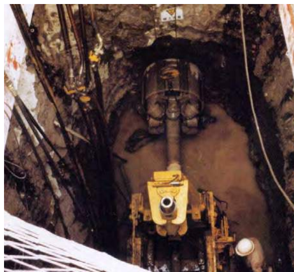
▲BM-100Nによる水平掘さく（宮城県） （ロックモール工法）
