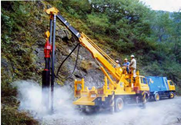
▲電柱設置孔施工（東京都）DD-10CSR
