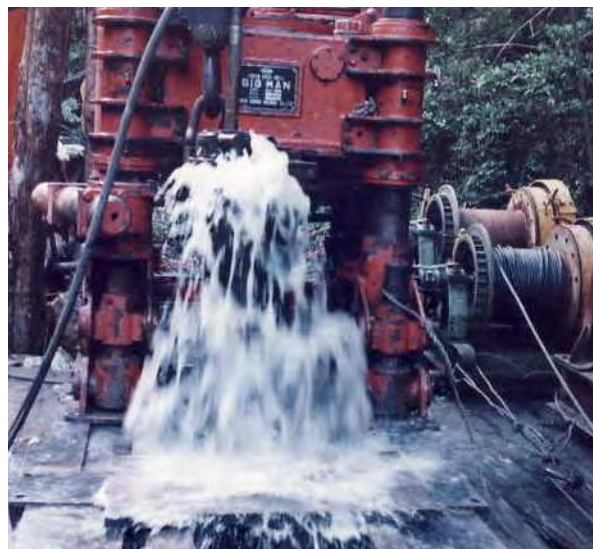
▲山陽新幹線福岡トンネルディープウエル掘さく BM-100K
