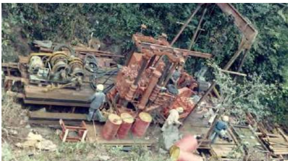
▲山陽新幹線福岡トンネル（福岡県） ディープウエル掘さく BM-100K
