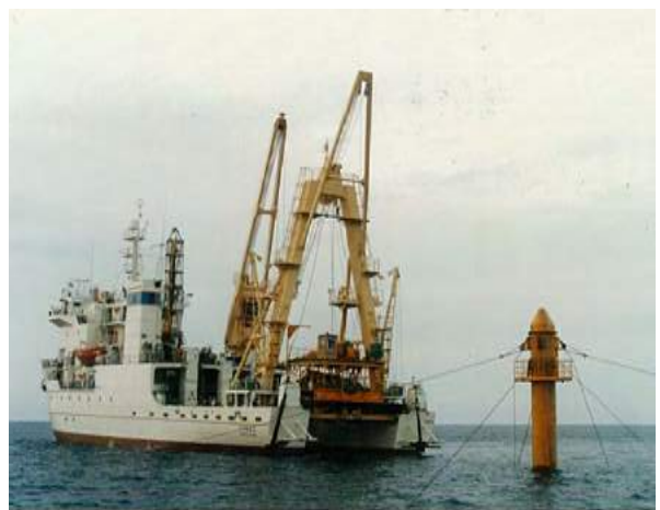
▲モノポッドの上に作業台とボーリングマシンを搭載する トリアス号 (ソ連・サハリン東岸沖)
