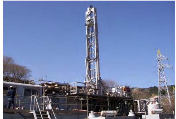
▲大岳発電所（大分県）地熱還元浚渫工事中のスピードSPAドリル SSD-4000
