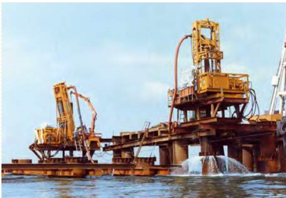
香港チャイナセメントプラント栈橋基礎杭工事 RBB-100A
