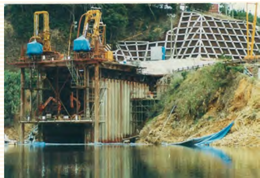
沖縄開発庁 福地ダム 鋼管矢板締め切り工事 ビッグマンシビル RBB-100A
