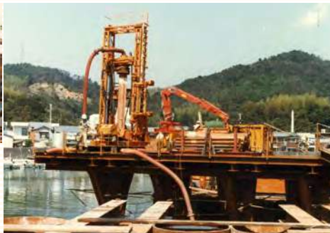
児島湾大橋下部工基礎杭工事 RBB-100A
