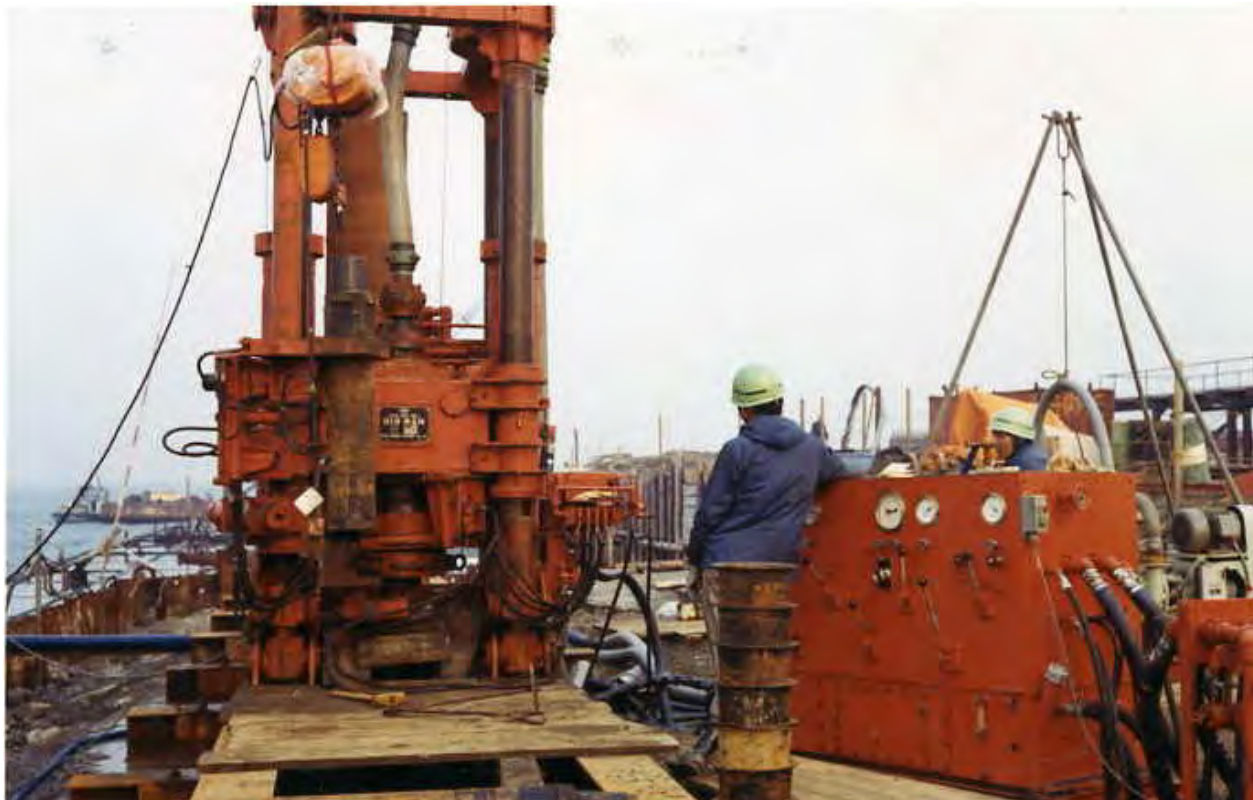
▲袖ヶ浦（千葉県）捨石層掘さく工事 BM-100K
