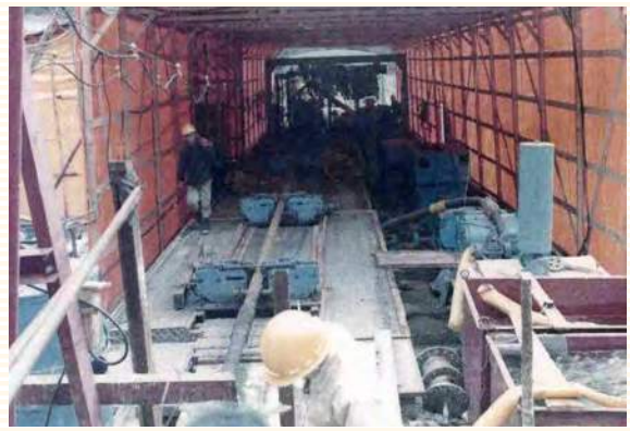
中津川線神坂トンネル(長野県)長尺水平ボーリング
