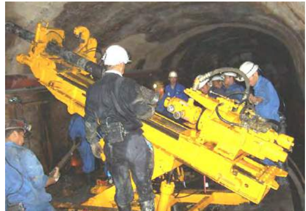
▲ベトナム マオケー 炭鉱水抜きボーリング中のアロードリル RPD-75SL-H2
