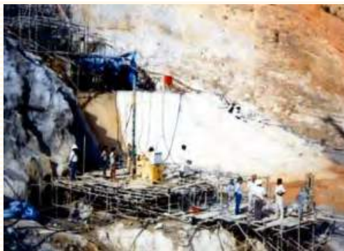
スリランカ・サマナラウエアダム グラウト工事
