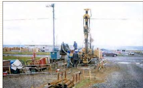
青森県深浦町 ガイア融雪システム DCHE設置工事 RPD-100C
