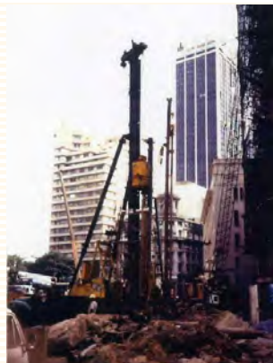
シンガポール地下鉄107A 土留杭工事
