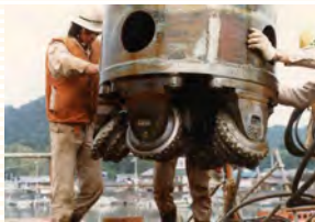
児島湾大橋下部工基礎杭工事 RBB-100A
