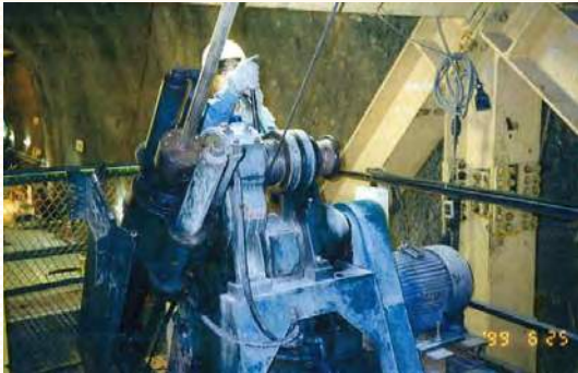
東京電力㈱神流川発電所圧力管路上向きボーリング
