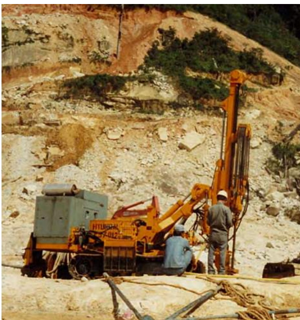
▲トレンガノ ケニールダム グラウト工事
