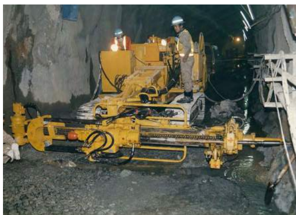
▲久慈地下石油備蓄（岩手県）水封ボーリング RPD-75C-E2
