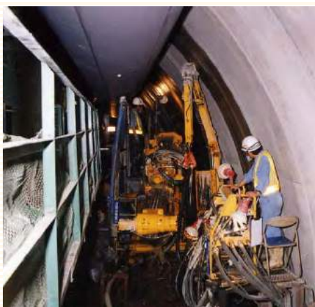
北陸新幹線 秋間トンネル水抜きボーリング RPD-100SL
