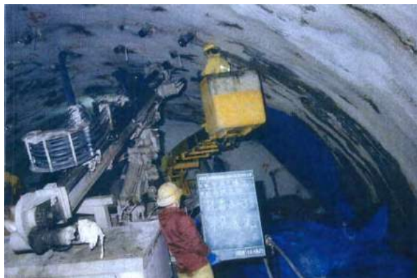
▲九州自動車道加久藤トンネル 注入工事
