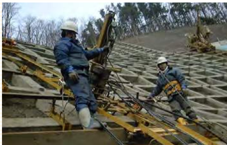
法面での無足場工法用ロックボルト施工機 ED-N1-A
