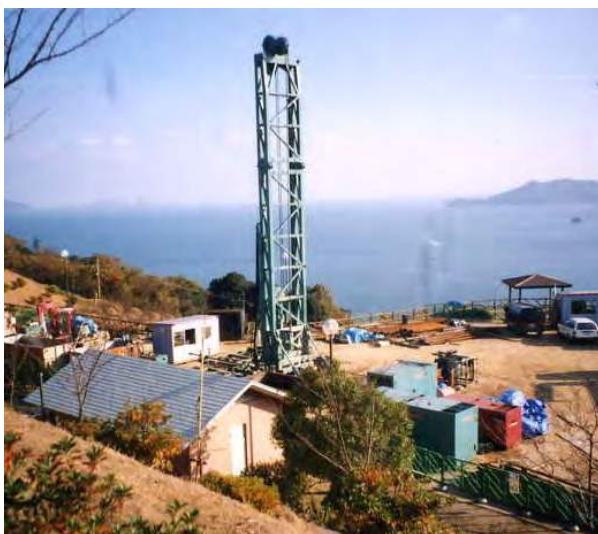
▲広島県呉市温泉掘さく SSD-3000
