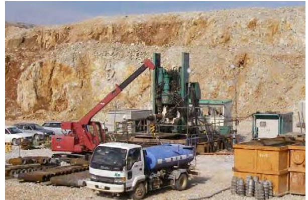
▲秋芳鉱山（山口県）径5.08m×深さ190m立坑掘さく工事 BM-500A
