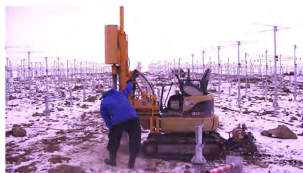
▲南極でアンテナ設置孔掘さく中のED-15P
