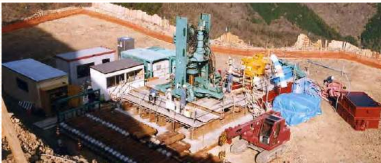
水資源開発公団 滝沢ダム(埼玉県)原石山立坑掘さく工事 BM-500A
