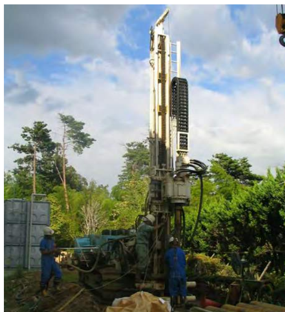
▲土壌汚染調査中のクローラードリル S-150
