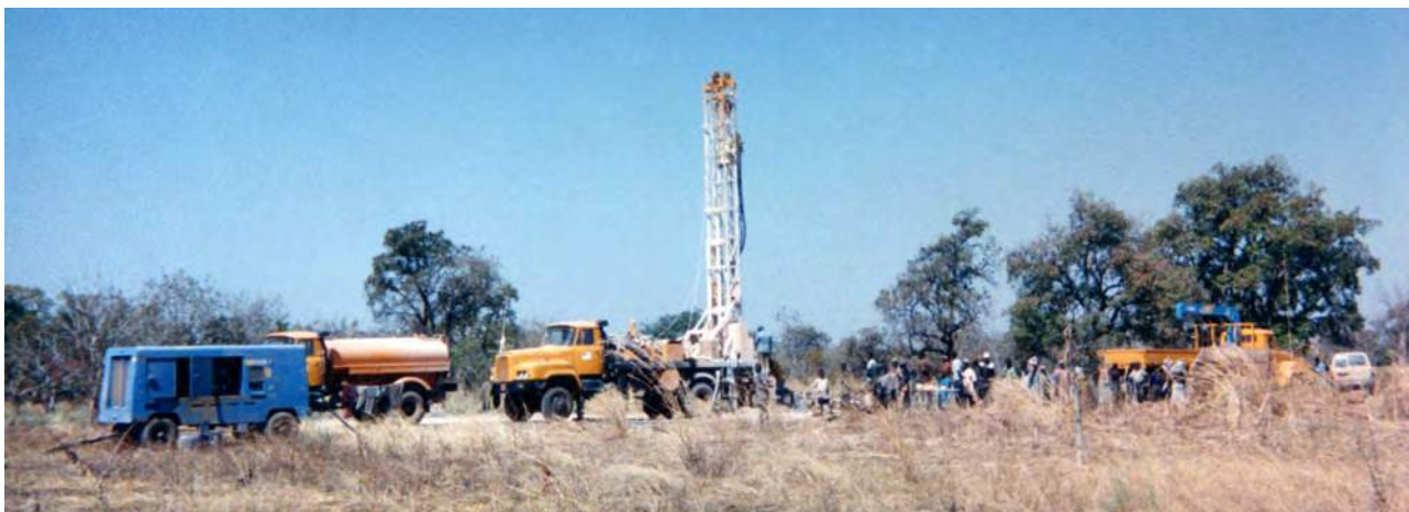
▲タンザニア 水井戸掘さく現場 FSW-7T
