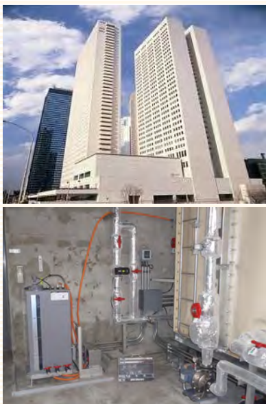
東京 京王プラザホテル 深層地下水活用システム
