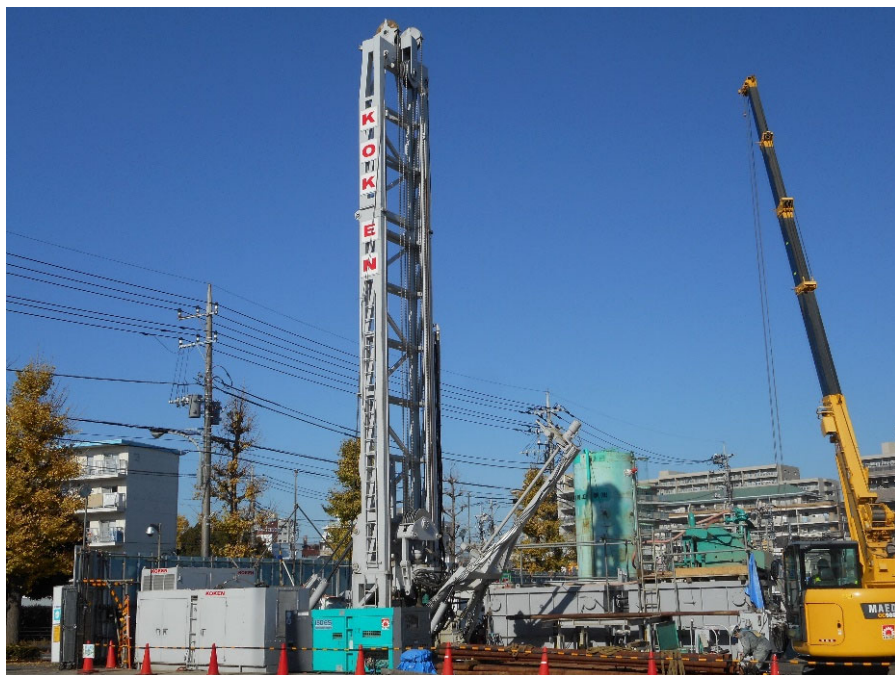
温泉掘削工事
