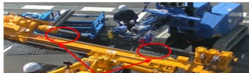
無線遠隔操作式ドリルロッド着脱
