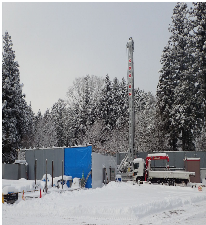
日光での温泉掘削
