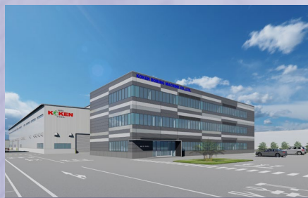
伊勢原新工場 稼働中
